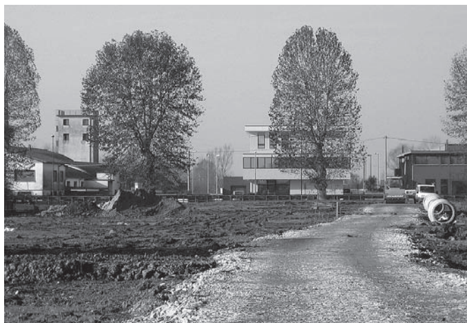
Lavori in corso per il nuovo ponte sul Muson dei Sassi.
