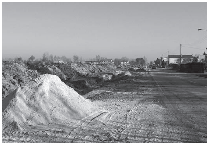
Lavori in corso in via Straelle.
