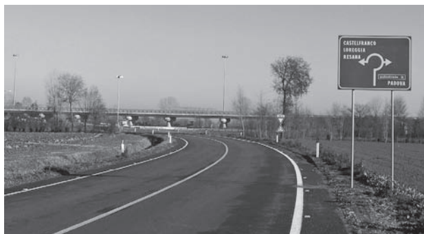
Bretella di svincolo della SR n. 308 in località Boscalto.
