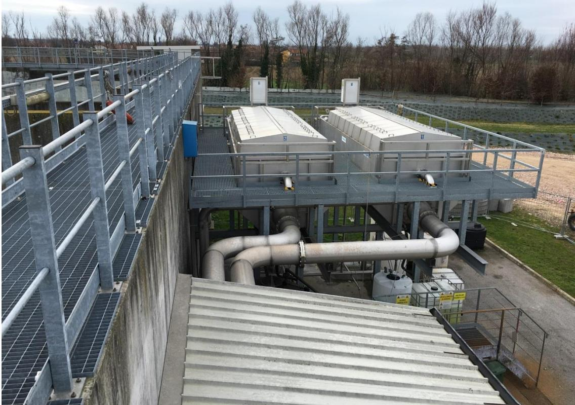
*Foto 6 : Filtri a dischi multipli SDF*
