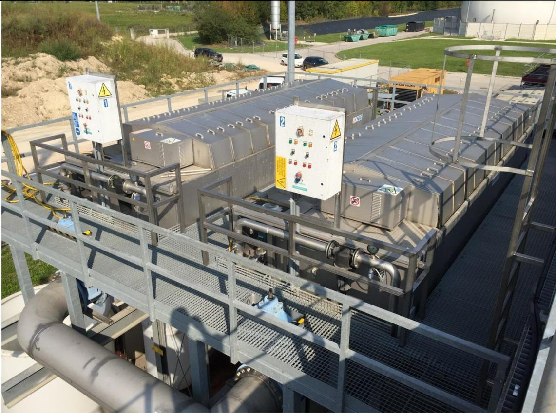
*Foto 6 : Filtri a dischi multipli SDF*
