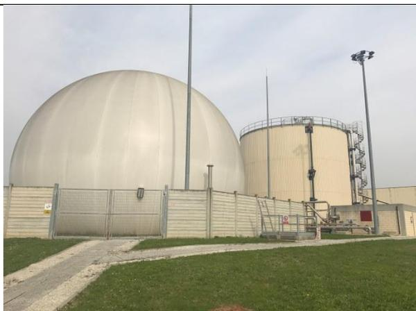
**Foto 3 : Digestore e Gasometro**
