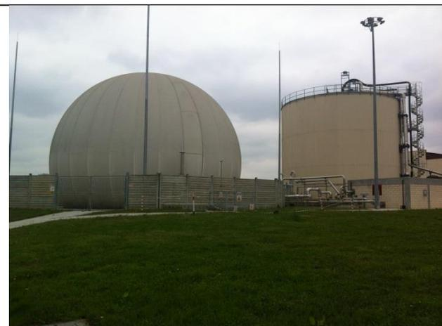
**Foto 3 : Digestore e Gasometro**
