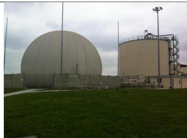
**Foto 3 : Digestore e Gasometro**
