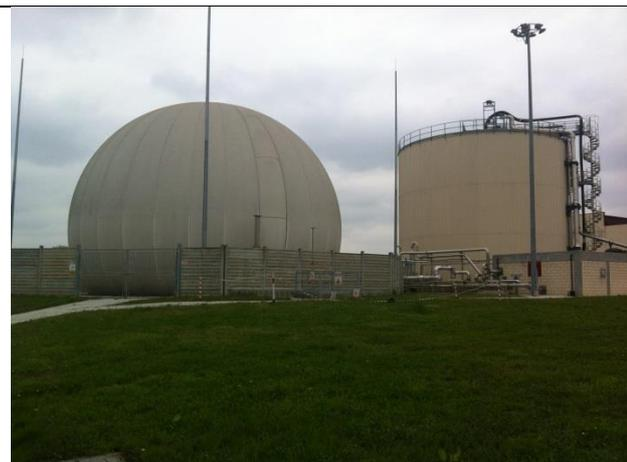
**Foto 3 : Digestore e Gasometro**
