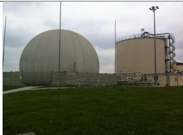
**Foto 3 : Digestore e Gasometro**
